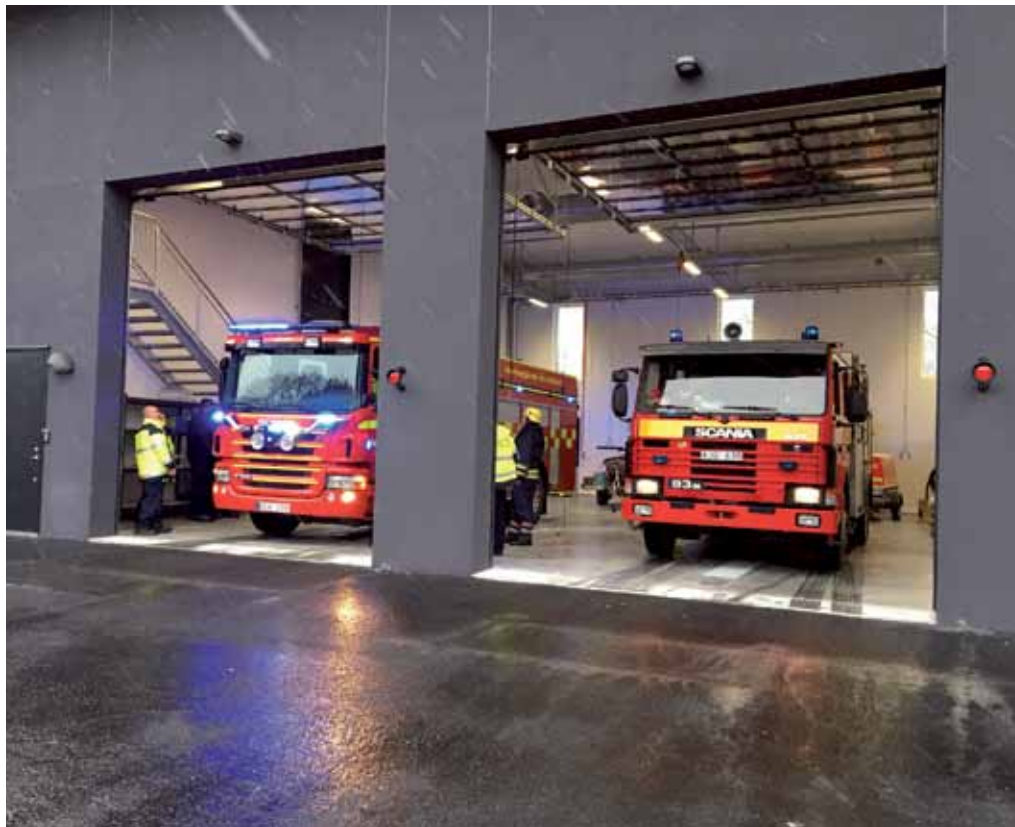
Den nya brandstationen i Skärblacka, tillhörande Räddningstjänsten Östra Götaland, har fått ny brandstation, ett stenkast från den gamla.
