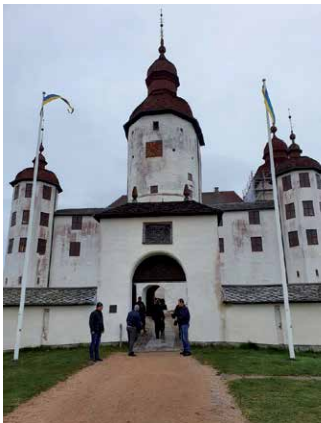
Att kombinera modernt brandskydd med 1600-talsmiljö är inte enkelt, det fick Kamratföreningens överstyrelse veta under sitt studiebesök.
