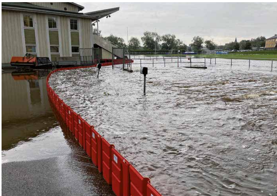
Hudiksvall drabbades hårt av stormen Hans och ledde bort vatten med hjälp av översvämningsskydd från NOAQ.
